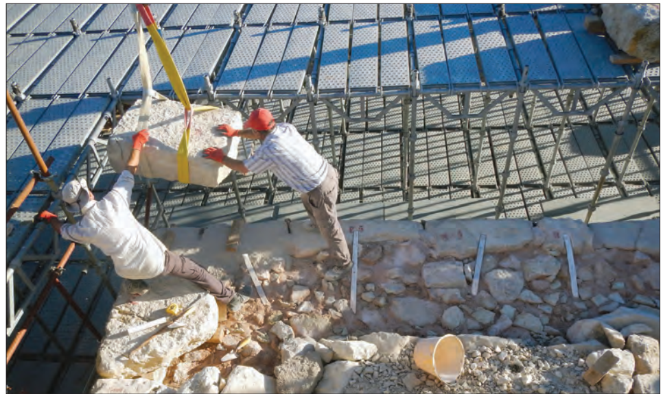
Şekil 4: Ekip, konservasyonu tamamlanan bloğu Erken Frig İç Kale Kapısı'ndaki orijinal pozisyonuna koyuyor. Çelik bantlar sağ ortada görülüyor. Fotoğrafçı Brian Rose.
