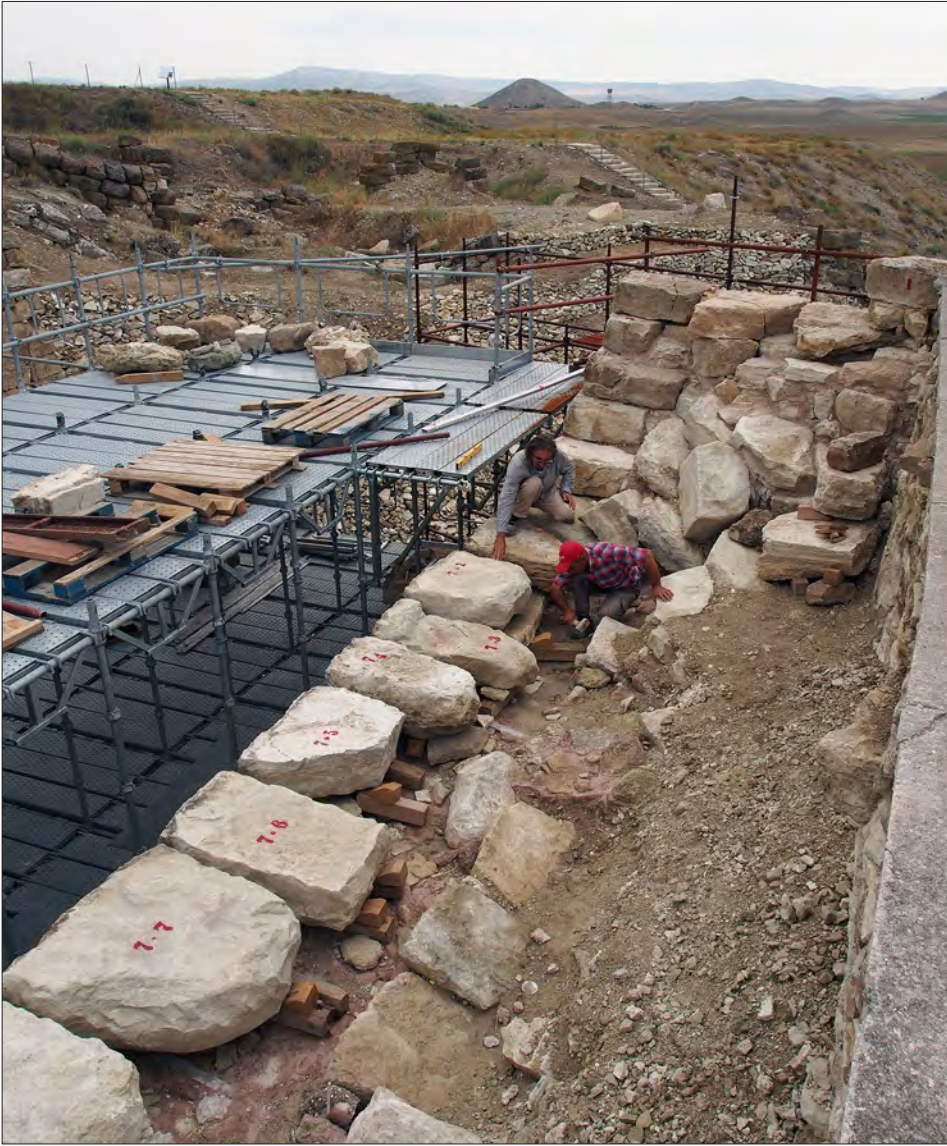
Şekil 5: Konservatör Angelo Lanza, konservasyonu tamamlanan yedinci taş sırasını yeniden yerleştiriyor. Arkaplanda Midas Höyüğü görülüyor. Fotoğrafçı Gebhard Bieg.
