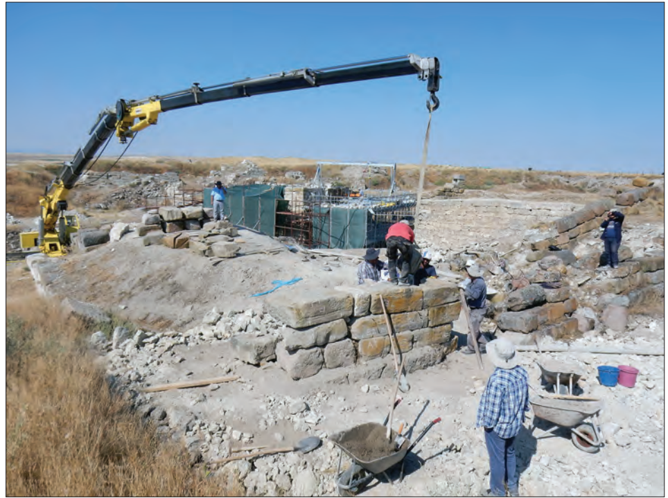
Şekil 8: Orta Frig İç Kale Kapısı'nın köşelerinden birinin taşınıp yeniden inşa edilmesi, batıya bakış. Fotoğrafçı Brian Rose.
