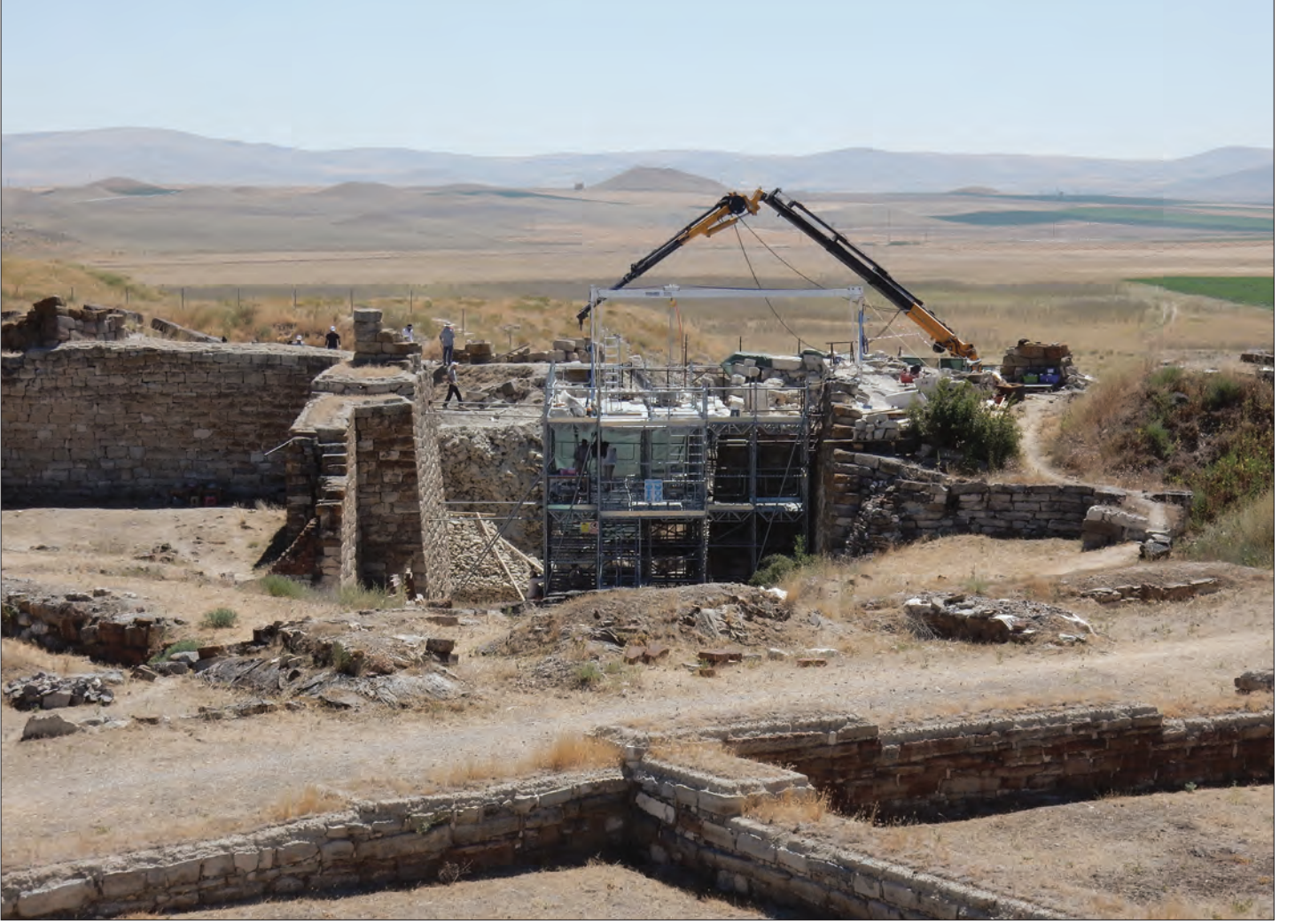
Şekil 2: Erken Frig İç Kale Kapısı'nın mimari konservasyonu, Tümlüs W'ya doğru doğuya bakış. Erken Frig Teras Binası'nın duvarları altta görülebilir. Fotoğrafçı Brian Rose.
