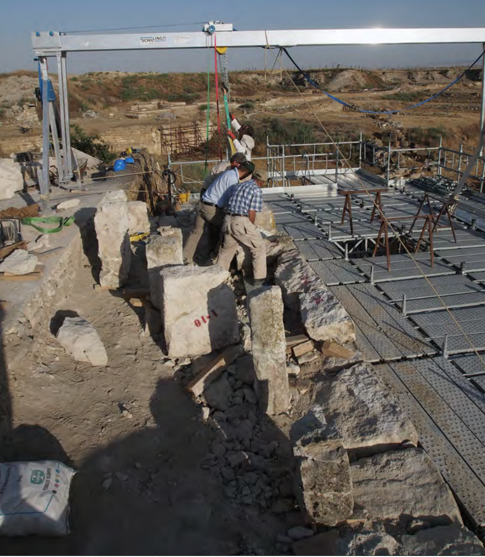
Şekil 4: Angelo Lanza ve ekibi Erken Frig İç Kale Kapısı'nın hasar gören duvarından bir taş sırası kaldırıyor. Yeni konservasyondan geçirilmiş taşların birkaçı arkalarında görünüyor. Fotoğrafçı Elisa del Bono.
