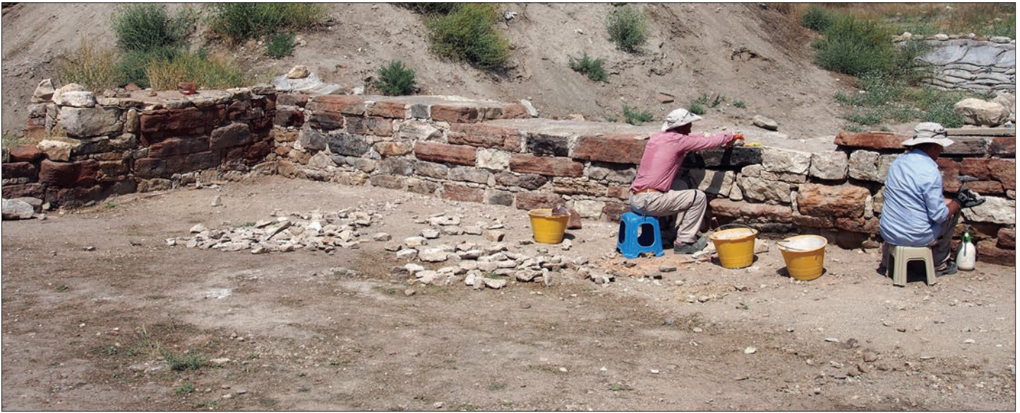
Şekil 4: Erken Frig Teras Binası'nda 5 ve 6 no.lu odaları ayıran duvar, konservasyondan önce. Fotoğrafçı Gebhard Bieg. Şekil 5: Erken Frig Teras Binası'nda 5 ve 6 no.lu odaları ayıran duvar, konservasyondan sonra. Fotoğrafçı Gebhard Bieg.
