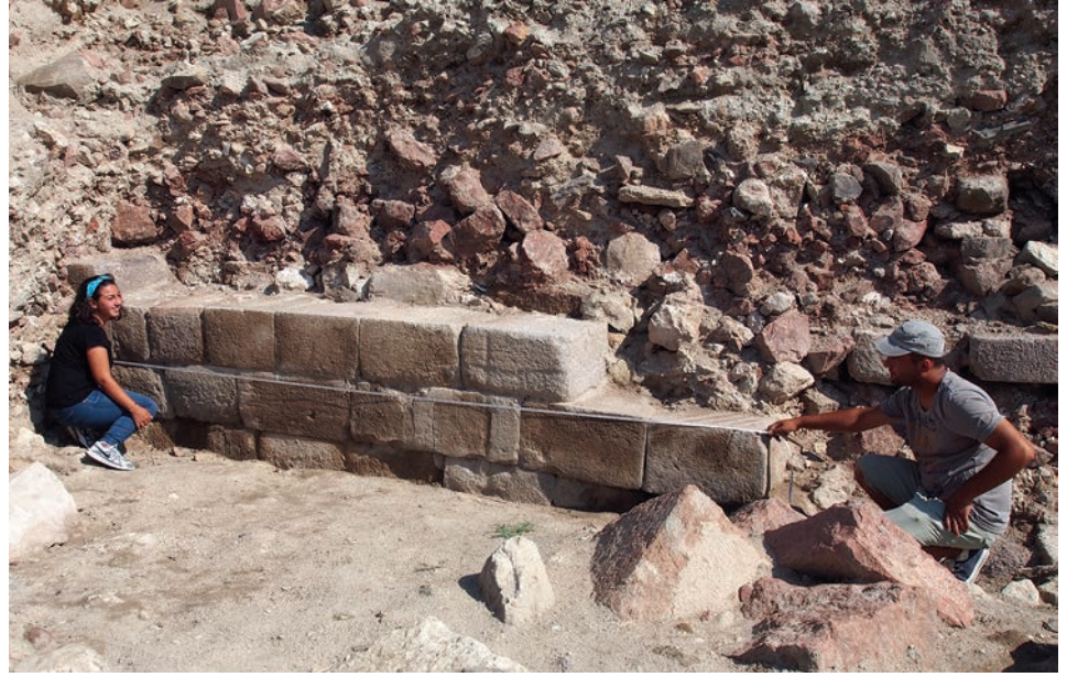
Şekil 13: Alan 1'de sokağı sınırlayan Orta Frig duvarı. Duvar Eda Kaygusuz ve Hüseyin Erol tarafından ölçüldü. Fotoğrafçı Gebhard Bieg.
