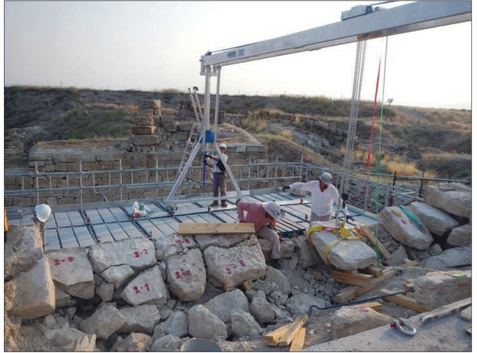
Şekil 2: Erken Frig İç Kale Kapısı'ndaki zarar görmüş blokların kaldırılması. Fotoğrafçı Gebhard Bieg.
