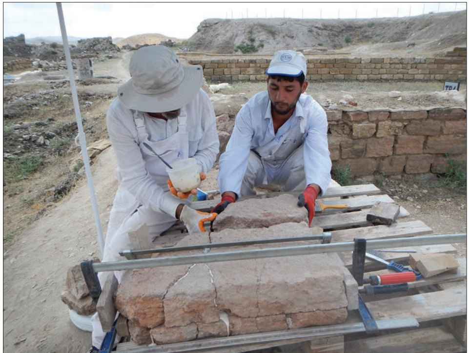
Şekil 3: Angelo Lanza ve Hüseyin Pehlivan Teras Binasındaki duvar bloklarından birini sağlamlaştırırken. Fotoğrafçı Brian Rose.
