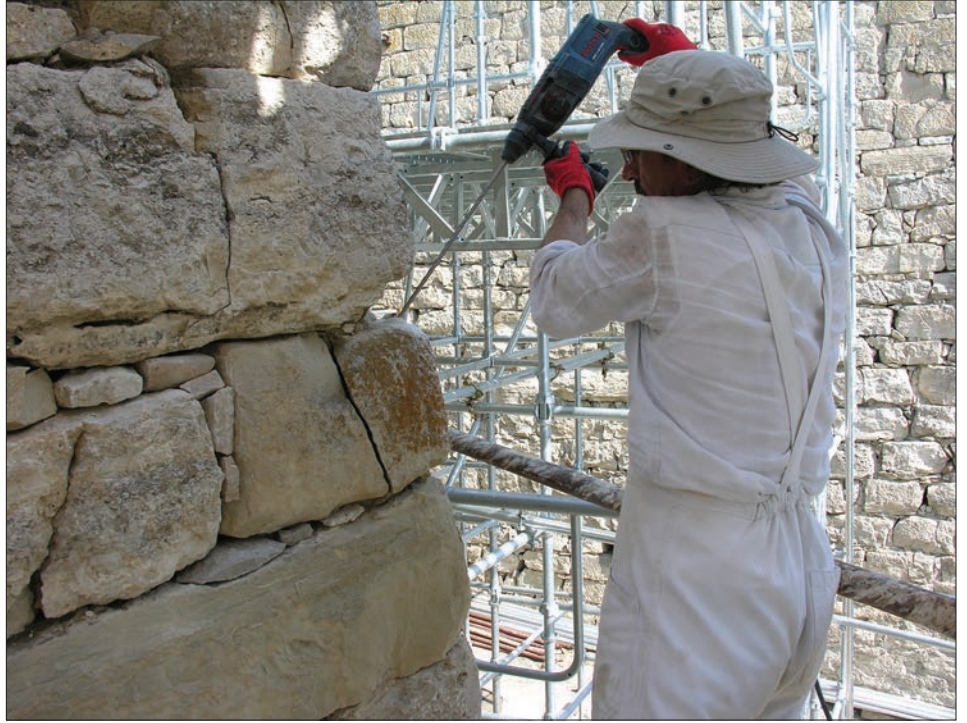
Şekil 2: Angelo Lanza paslanmaz çelik çubuklar monte ederek Erken Frig Kapısı'ndaki duvar bloklarından birini güçlendirme için hazırlarken. Fotoğrafçı Elisa del Bono.
