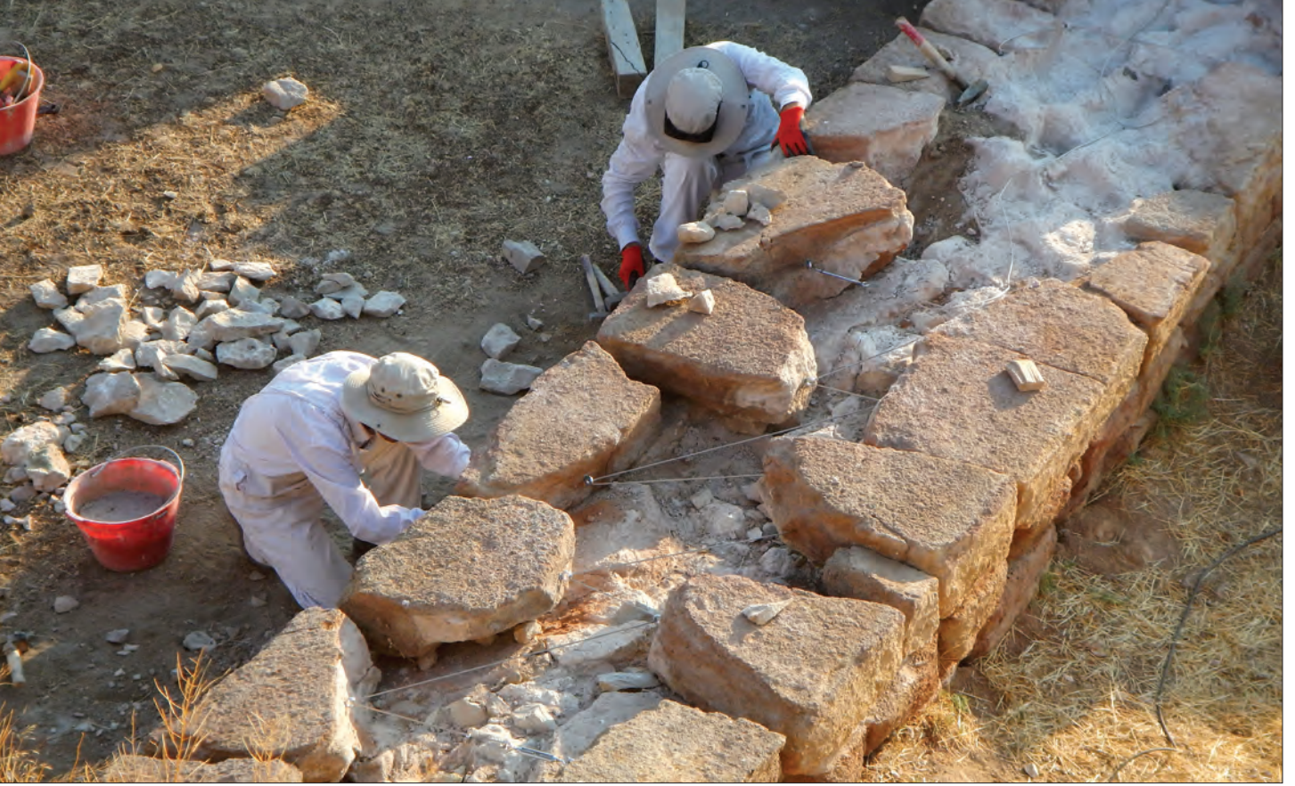
Şekil 2: Angelo Lanza Teras Binası'ndaki duvar taşlarından birini çelik halatlarla sağlamlaştırırken. Fotoğrafçı Brian Rose.
