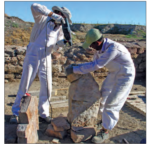
Şekil 2: Angelo Lanza, Teras binasının duvar bloklarını sağlamlaştırırken. (Fotoğraf: Elisa del Bono)
