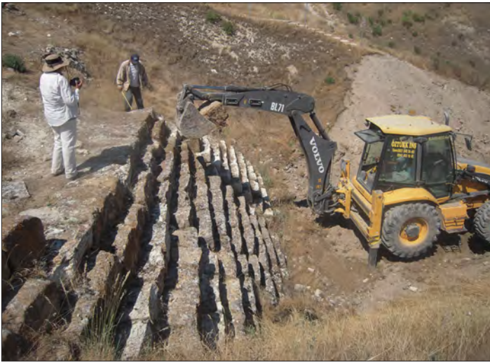
Şekil 11: Basamaklı şeve taşların yerleştirilmesi.
