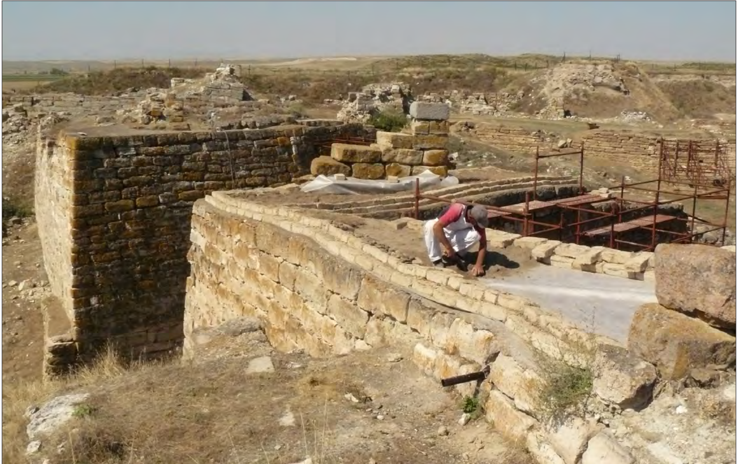
Şekil 9: Gordion, Erken Frig Kapısı'na “soft-capping” yerleştirilmesi.
