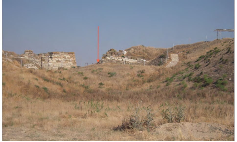
Şekil 10: Erken Frig Kapısı ve şevin çalışmalara başlanmadan önceki hali.
