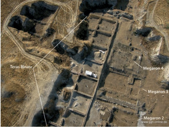
Fig. 20 - Teras Binaları, havadan görünüm.
