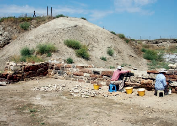
Fig.72 -Teras Binaları, restorasyon-konservasyon çalışmaları.
